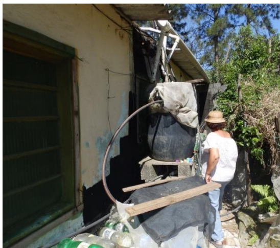
Figura 7 – Residência que faz a captação de água da chuva.
