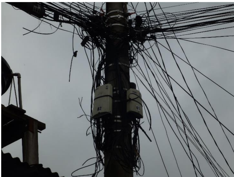
Figura 23 – Exemplo de furto na rede na energia elétrica em Santa Cruz dos Navegantes.
