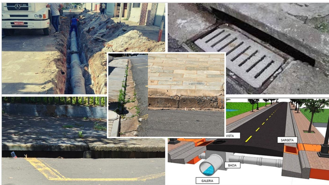
QUADRO 5: ELEMENTOS DE MICRODRENAGEM TRADICIONAL
